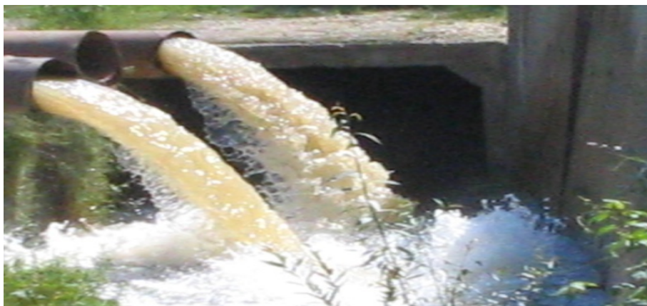
Figura 1. Lucrări de asecare și de drenare a apelor (canal de gardă, stație de pompe)
