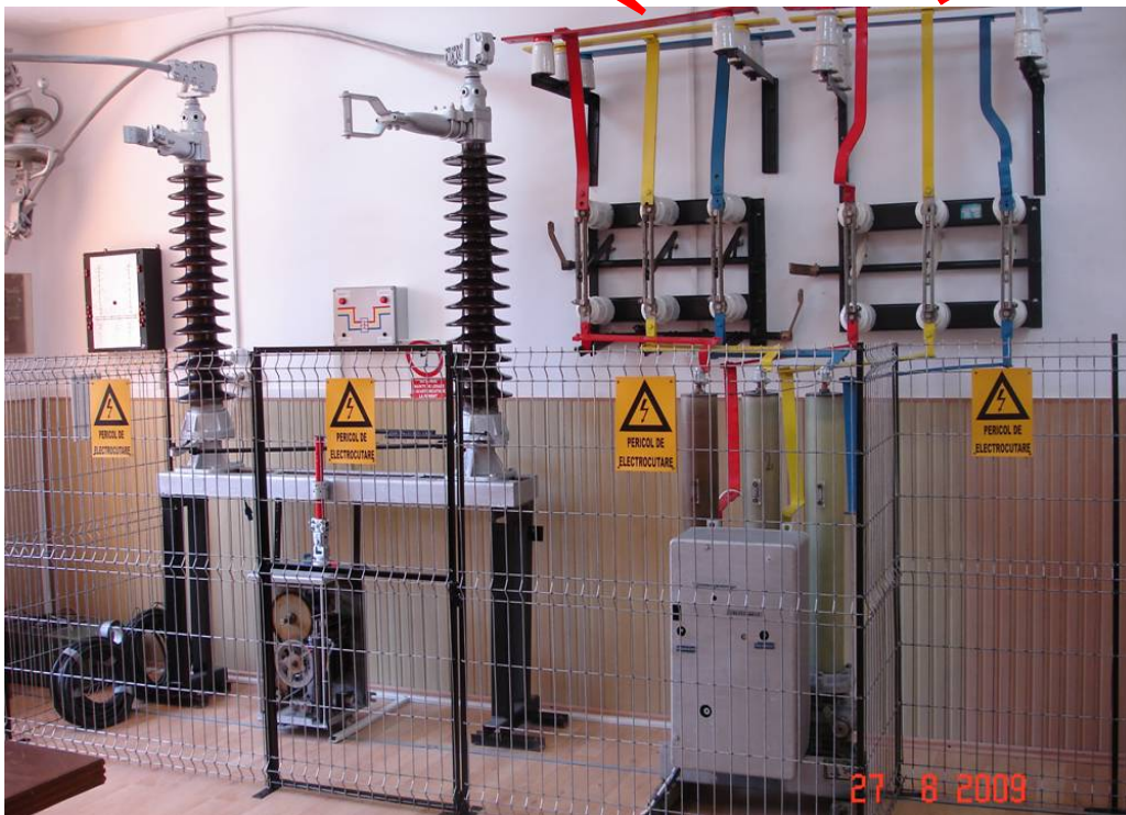
Fig.2.Ministație electrică ce încorporează dispozitivul de A.A.R.
