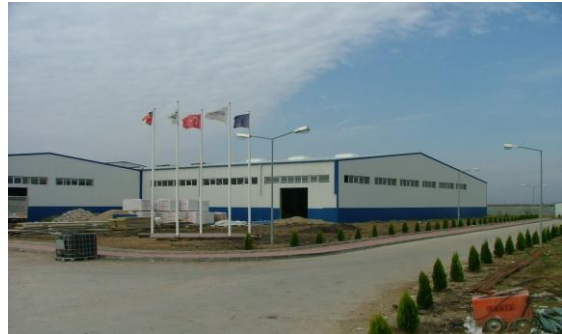
Fig. 11. Construirea unui depozit de construcții Fig. 11. Construction of a warehouse
